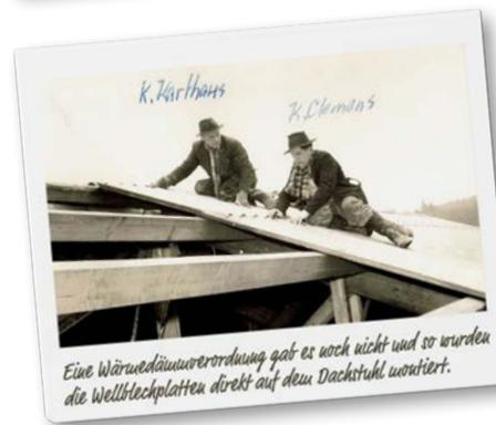
Eine Wärmedämmverordnung gab es noch nicht und so wurden die Wellblechplatten direkt auf dem Dachstuhl montiert.
